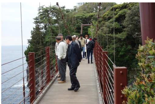
城ヶ崎海岸吊り橋
