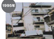
地震による倒壊 阪神・淡路大震災 (日本損害保険協会提供)
