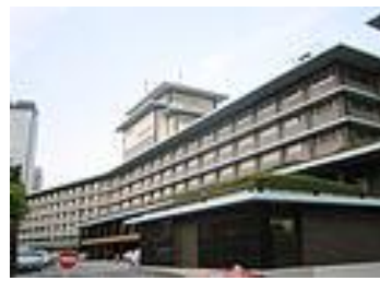
解体中のホテルオークラ旧本館
